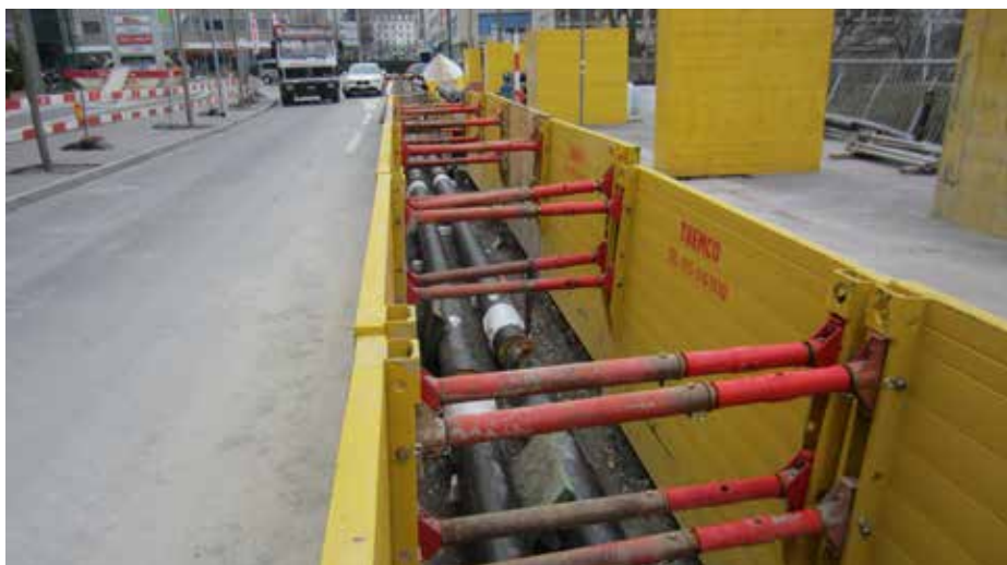
Fernwärmebau in der oberen Quaderstrasse
