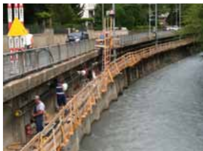
Leitungsbau am Plessurquai
