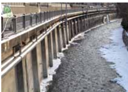
Leitungsführung unter dem Plessurquai
