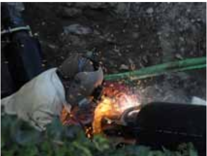
Ausführung einer röntgen-sicheren Schweissnaht
